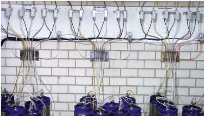
Tanklager mit Durchflussmesstechnik für Ausschankkontrolle von Bier (rechts) und AFG-Getränken (links).
