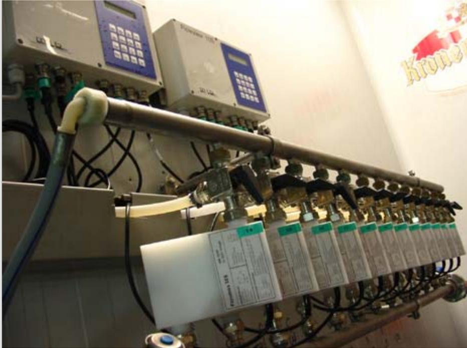
*Tankkeller mit Bierverteiler und Messgerät Flowmax 30S.
