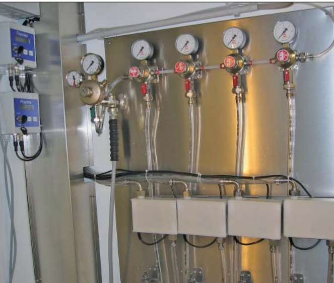
Installation der Messtechnik.
